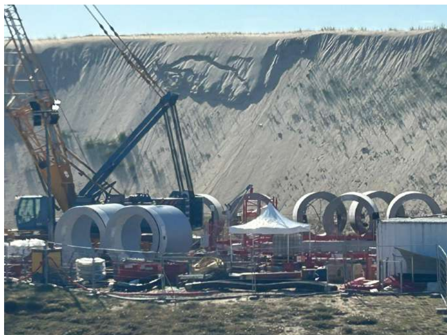
Maintenant , pendant les travaux de forage du puit, le forage du tunnel n'avait pas encore commencé lors de la prise de la photo .....
