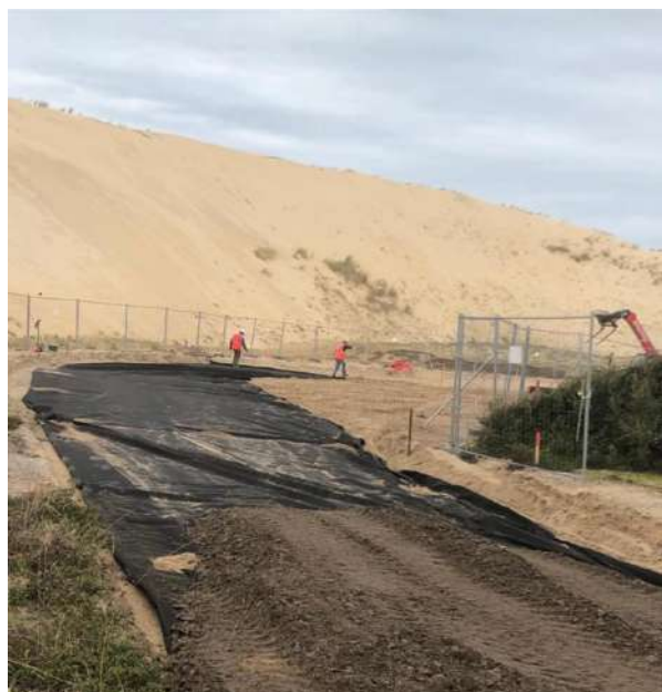
Avant travaux du puit et du tunnel
